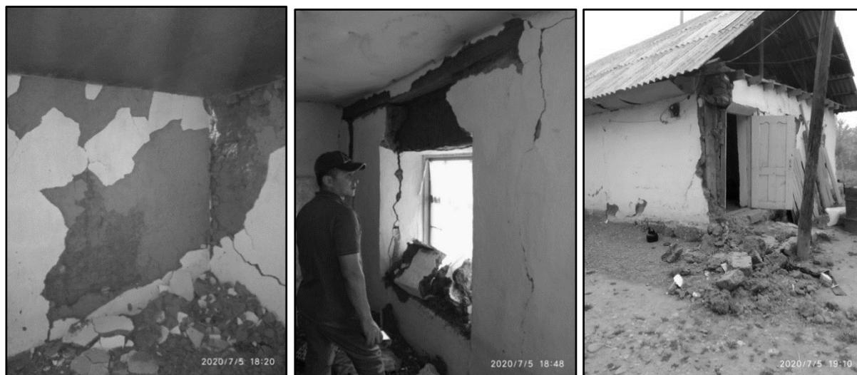
*Рис. 6.* Сквозные зияющие трещины (вид снаружи) и обрушение штукатурки стен жилых домов в селении Ганишоб
