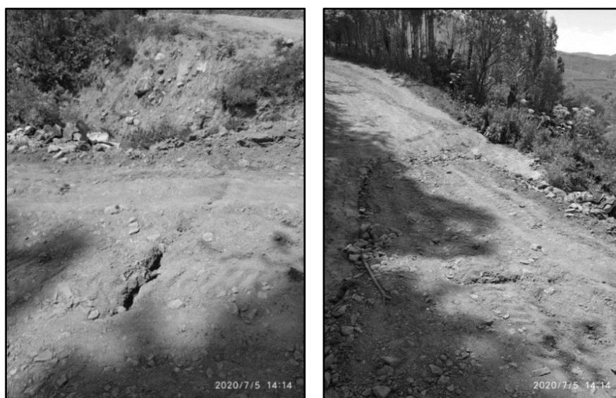
*Рис. 7.* Поперечная трещина и просадка грунтовой дороги в восточной части кишлака Себистон
