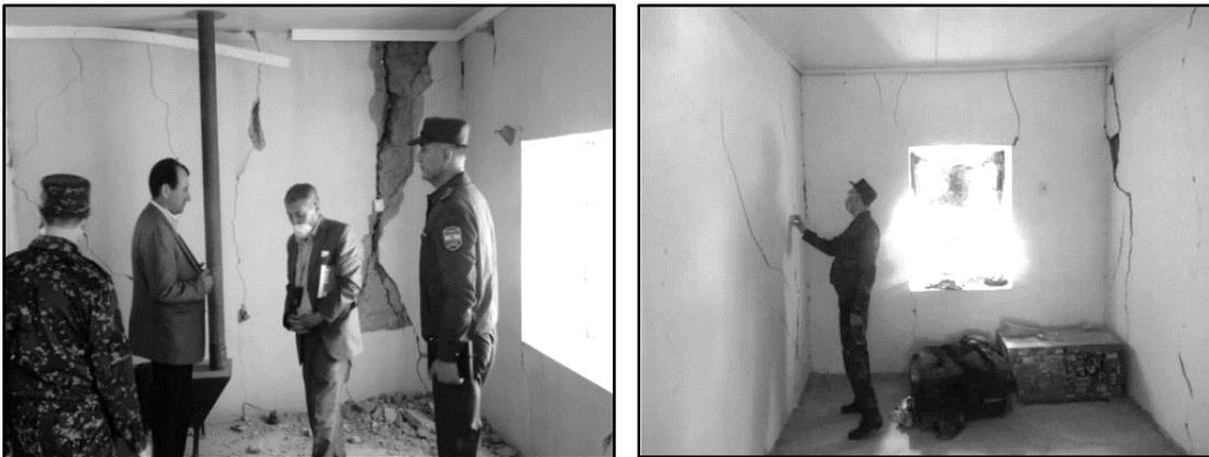
**Рис. 5.** Сквозные трещины и выпадение больших кусков штукатурки на стенах глинобитного жилого дома
