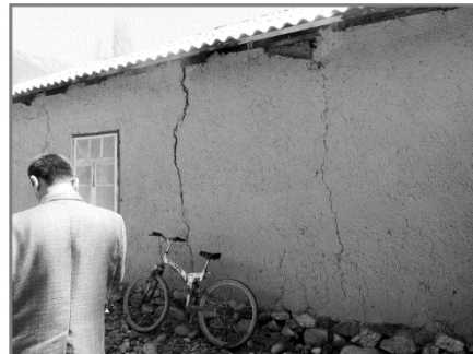
Рис. 8. Кишлак Ачкалма, обрушение части стены и сквозные трещины в стенах жилых домов
