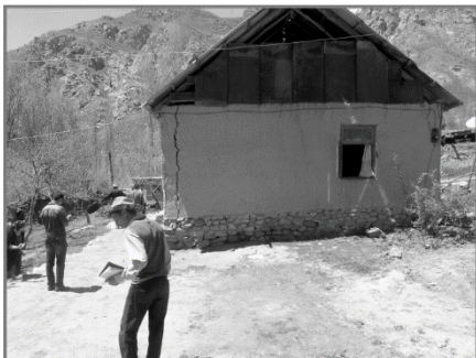
Рис. 9. Кишлак Дувана, сквозные трещины на стенах глинобитных домов
