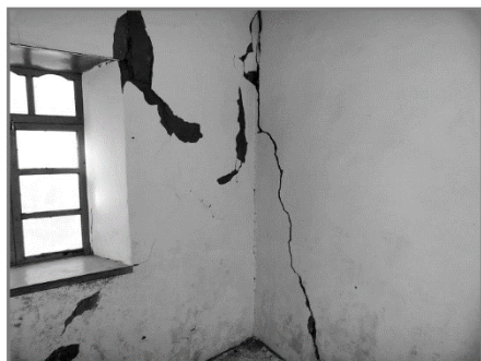
Рис. 10. Кишлак Оксой, примеры повреждений жилых глинобитных домов
