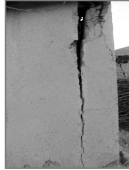
Рис. 5. Кишлак Килчуджой, повреждения глинобитных домов
