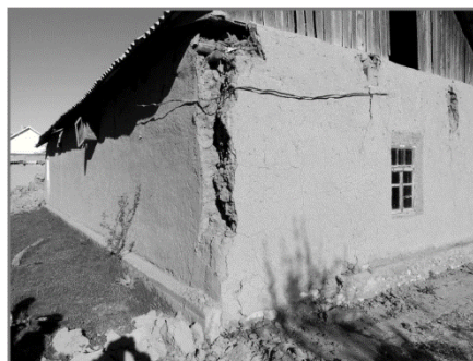
Рис. 10. Кишлак Оксой, примеры повреждений жилых глинобитных домов
