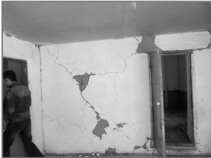
Рис. 6. Кишлак Карамык, сквозные трещины на стенах и углах жилого дома
