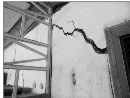
Рис. 7. Кишлак Саргой, обрушение части стены и сквозные трещины в стенах жилых домов
