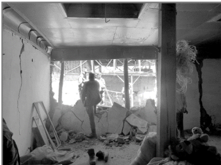
Рис. 8. Кишлак Ачкалма, обрушение части стены и сквозные трещины в стенах жилых домов
