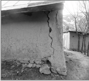
Рис. 5. Кишлак Килчуджой, повреждения глинобитных домов
