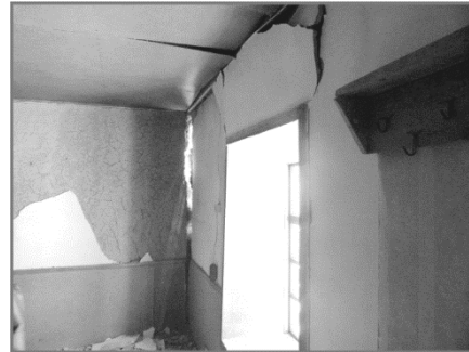
Рис. 6. Кишлак Карамык, сквозные трещины на стенах и углах жилого дома
