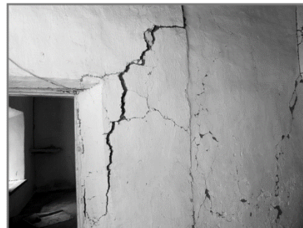
Рис. 9. Кишлак Дувана, сквозные трещины на стенах глинобитных домов
