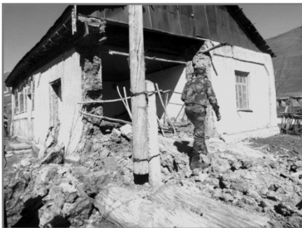
Рис. 7. Кишлак Саргой, обрушение части стены и сквозные трещины в стенах жилых домов
