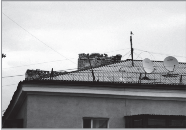
Рис. 6. Вид кирпичной вентиляционной трубы на крыше 4-этажного здания старой застройки в г. Абае
