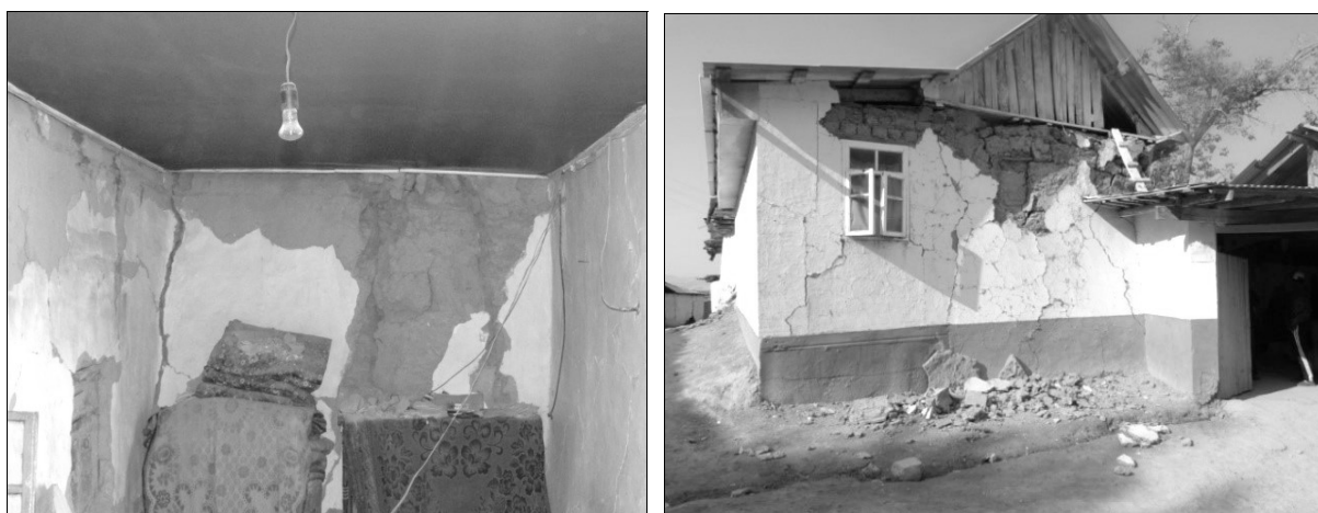
Рис. 7. Характерные повреждения глинобитных домов в эпицентральной зоне
