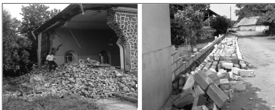
Рис. 3. Поврежденные здания в деревне Базар Загатальского района
