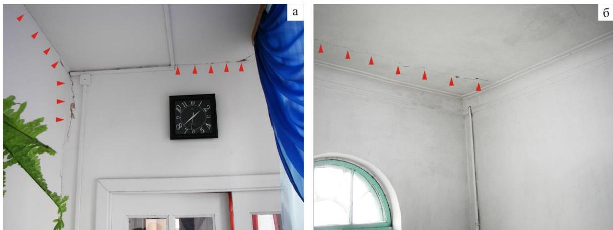
**Рис. 7.** Повреждения штукатурки (указано красными стрелками) в зданиях при Заганском землетрясении а – в здании психоневрологического диспансера, с. Новый Заган; б – в двухэтажном деревянном здании Дома детского творчества, с. Мухоршибирь.
