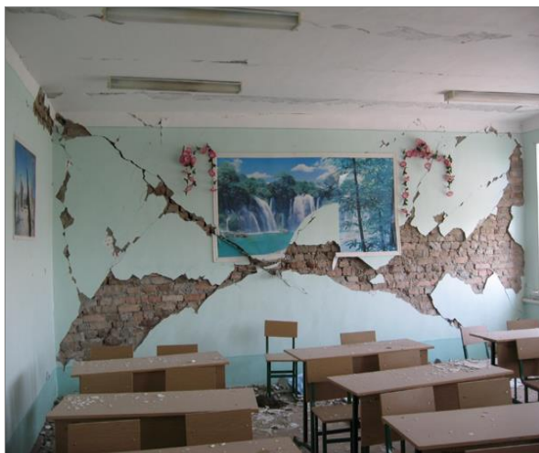
Рис. 8. Риштан: крестообразные трещины в стене классной комнаты на третьем этаже (Джураев А., 2011)
