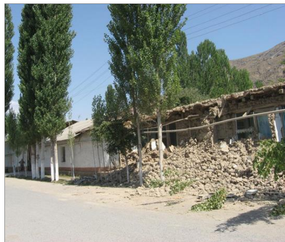
Рис. 9. Обрушение дома из сырцового кирпича в п. Сох Багдадского района Ферганской области Узбекистана (Усманова М.Т., 2011)
