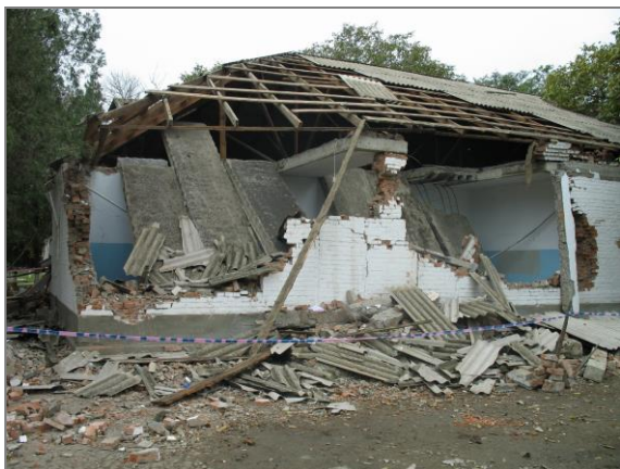
Рис. 2. Разрушенное частное здание в Курчалое
