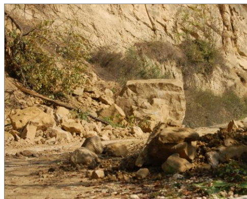
Рис. 30. Осыпи и камнепад на автодороге Герзель–Замай-Юрт в Ножай-Юртовском районе
