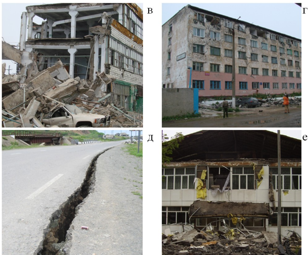
Рис. 1. Примеры повреждений, вызванных Невельскими землетрясениями: сквозная трещина несущей стены шлакоблочного здания (а); обрушение лестничных пролетов 4-этажного здания (б); разрушение цеха сетеповиша (в); разрушения фасада здания общежития «Бригантина» (г); трещина дорожного полотна (д); разрушения дома культуры г. Невельска (е). Авторы фотографий В.М. Кайстренко, Н.С. Коваленко
