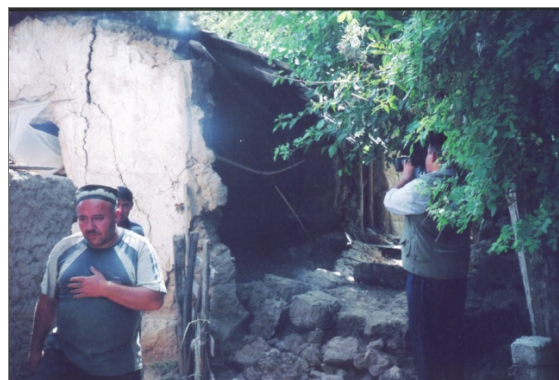
Рис. 7, 8. Повреждения части жилого глинобитного дома и подсобного помещения в селениях Казнок и Качаманди по правому борту р. Сурхоб
