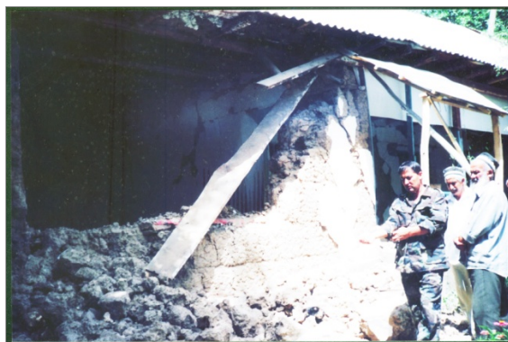
Рис. 7, 8. Повреждения части жилого глинобитного дома и подсобного помещения в селениях Казнок и Качаманди по правому борту р. Сурхоб
