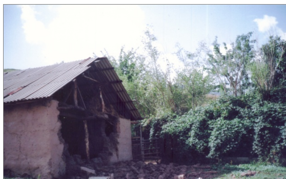
Рис. 5, 6. Повреждения части жилого глинобитного дома и подсобного помещения в селениях Кулоба и Чугдабион по левому борту р. Сурхоб
