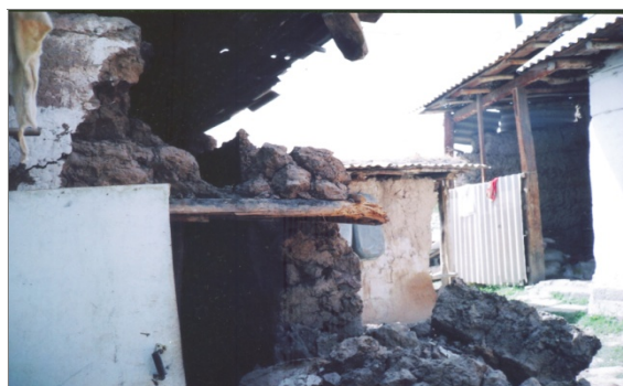
Рис. 5, 6. Повреждения части жилого глинобитного дома и подсобного помещения в селениях Кулоба и Чугдабион по левому борту р. Сурхоб
