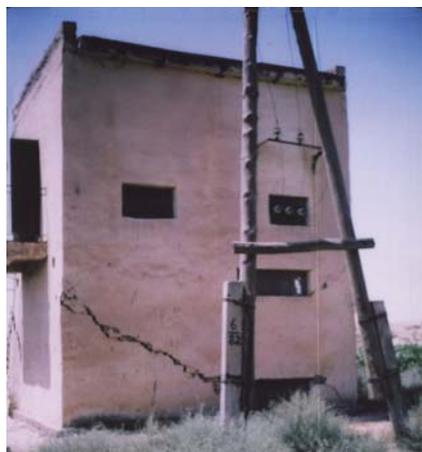
**Рис. 4.** Повреждение здания электроподстанции (жженный кирпич)
