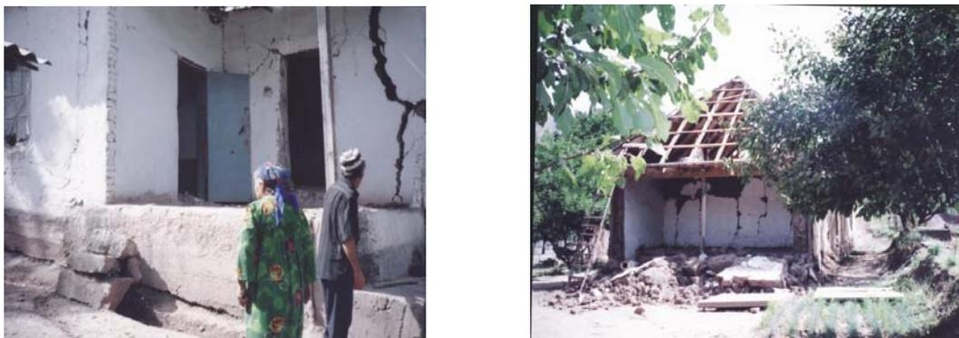
**Рис. 3.** Характерные повреждения глинобитных домов в эпицентральной зоне Кумсангирского землетрясения 29 июля 2006 г.
