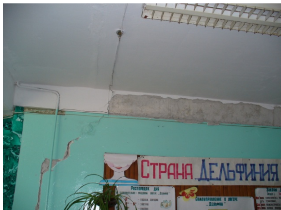
Рис. 5. Трещины в штукатурке недавно отремонтированного здания интерната в пос. Горнозаводск
