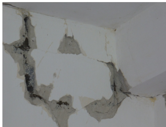
Рис. 5. Трещины в штукатурке недавно отремонтированного здания интерната в пос. Горнозаводск
