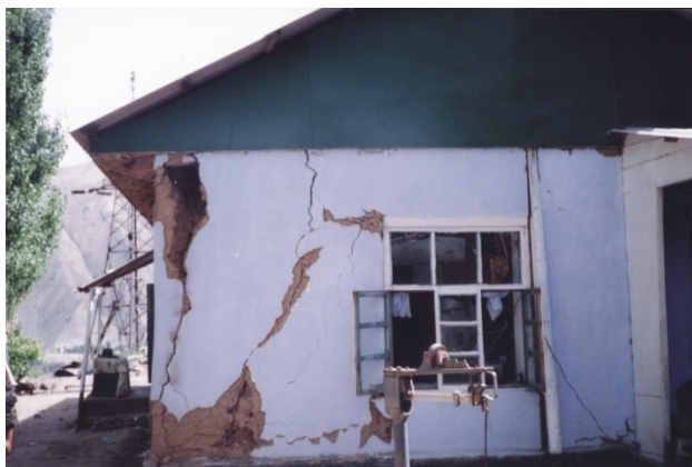
Рис. 3, 4. Характерные повреждения глинобитных домов в эпицентральной зоне
