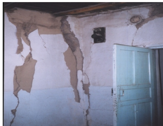
Рис. 3, 4. Характерные повреждения глинобитных домов в эпицентральной зоне
