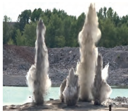
Короткозамедленный взрыв на обводненной части карьера
